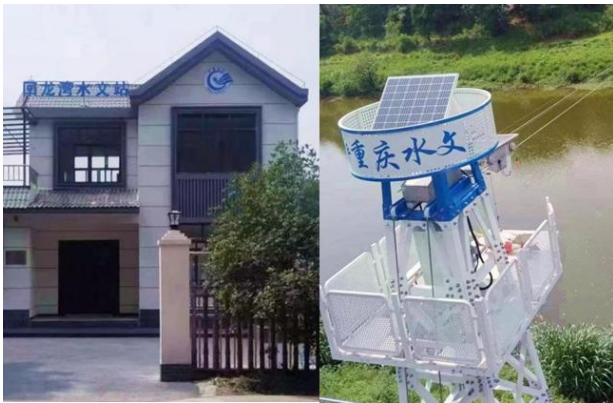
图 8 回龙湾水文站整改提升建设
